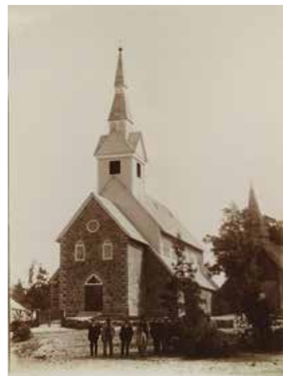
Runö stenkyrka när den byggdes. Några byggnadsarbetare och en stege rest mot väggen. Foto: Theodor Jasner
