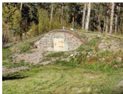
Korsi talu vastrenoveeritud kelder
